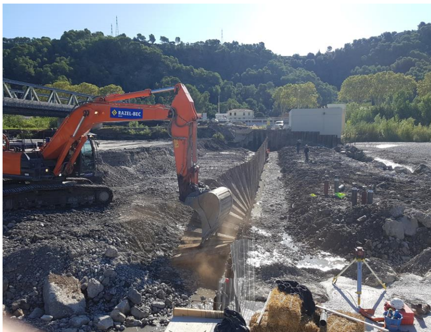
Abaissement Seuil 7 - Arasement palplanche
