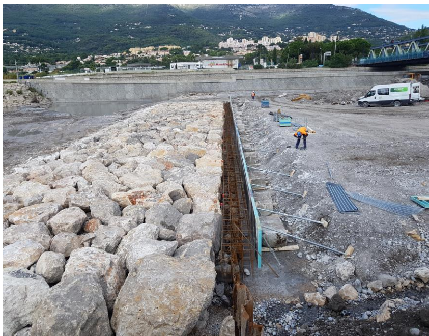
Abaissement Seuil 7 - Coulage longrine protection palplanche
