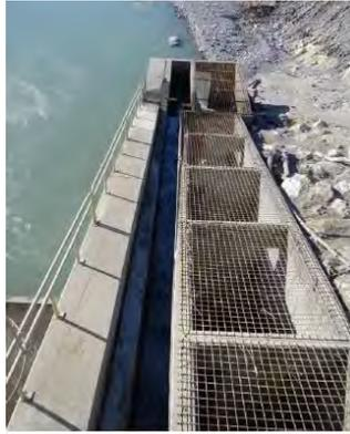
Figure 34 : Figure 33 : Passe de montaison du seuil n°16 (source ARTELIA)
