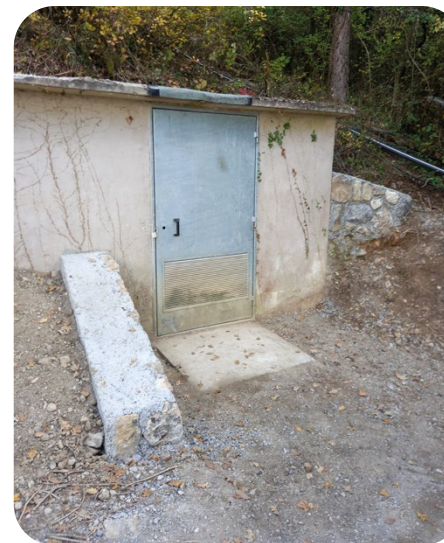
Travaux en cours de rénovation d'un local surpresseur
