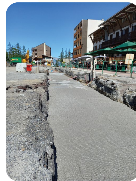
Remblaiement tranchée en grave autostable
