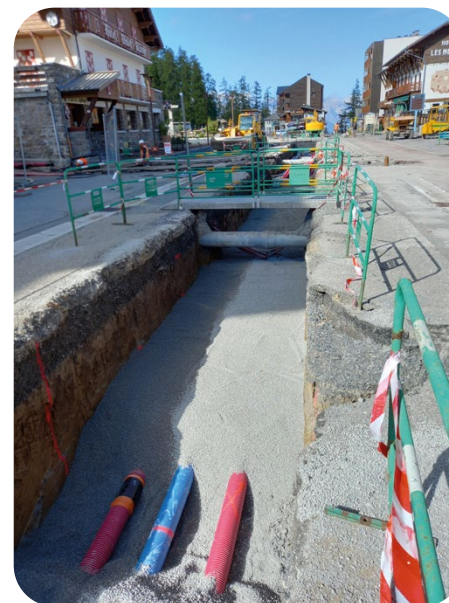
Pose du réseau eau potable en bleu
