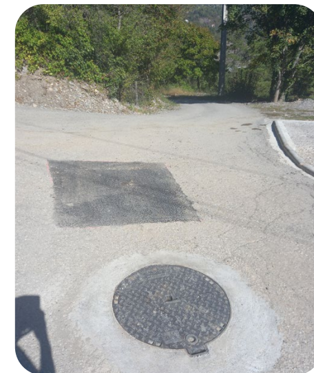
Remise à la côte d'ouvrages eau potable
