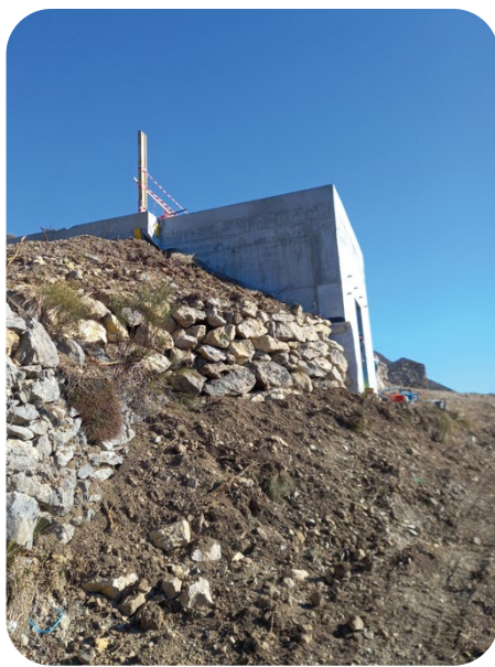
Extérieur du réservoir
