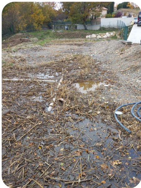
Etat des lieux avant travaux
