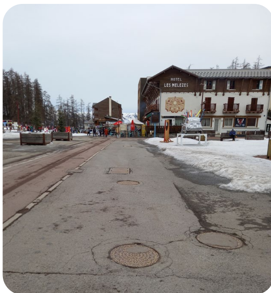
Regard de visite du réseau eaux usées
