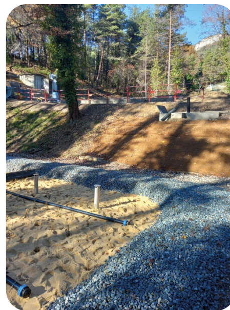
Travaux en cours de réalisation
