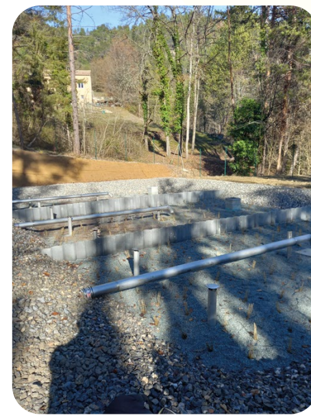
1 er étage de filtration des eaux usées
