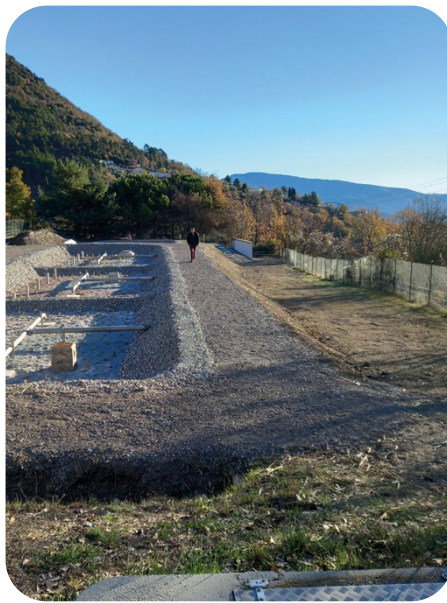
Etat des lieux après travaux
