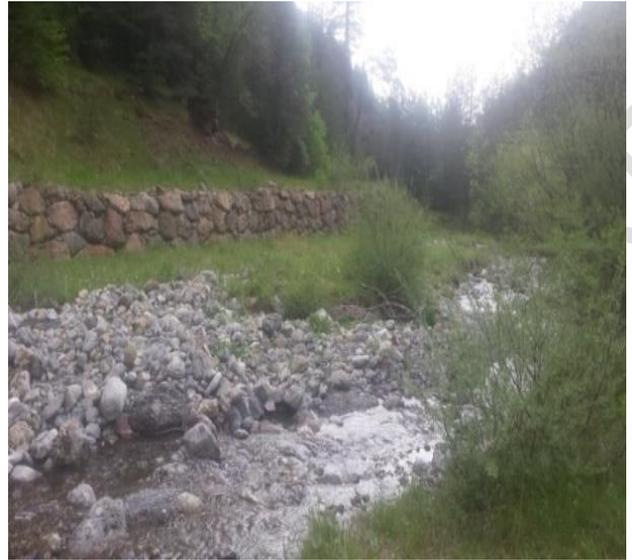
Photographies 5 et 6 : Stabilisation pour le maintien de la route D28 (gauche), stabilisation du versant pour l'alimentation du ruisseau pépinière (droite) – Source : G. Weible
