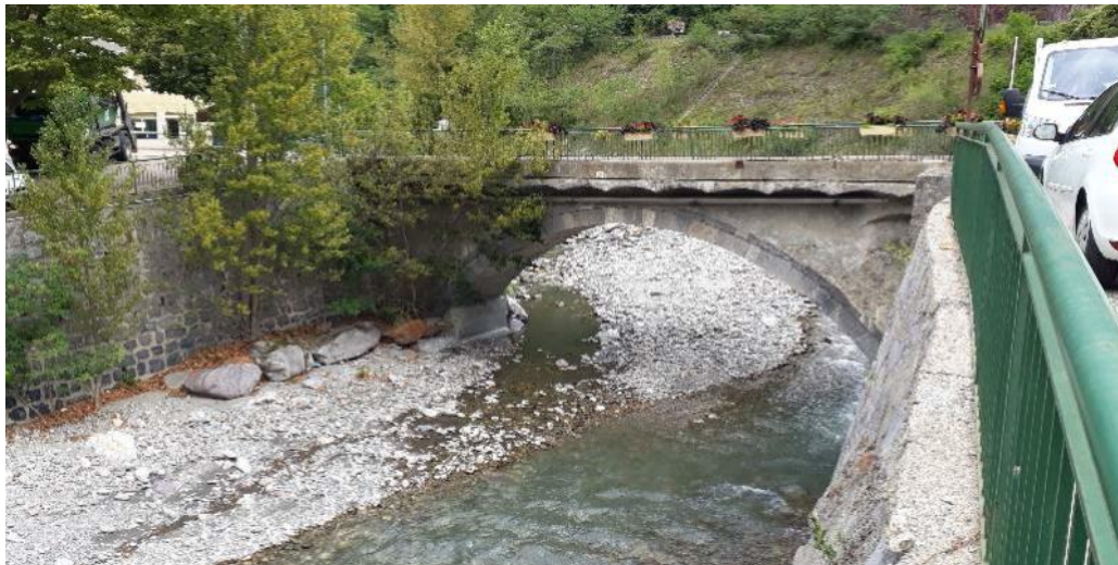
Figure 11 - Pont de Saint-Sauveur-sur-Tinée
